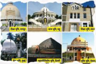
अम्बेडकर पंचतीर्थ निर्माण
